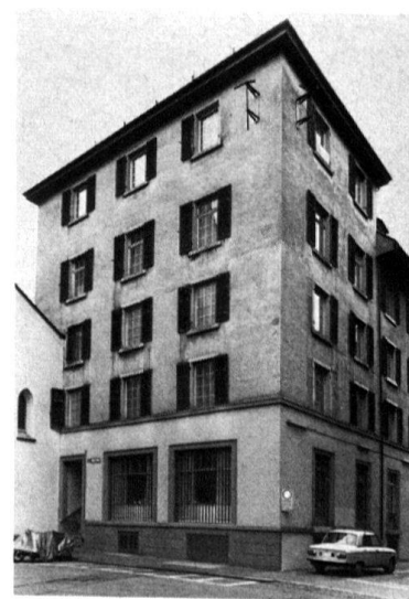
2 Zürich. Altbau, Nordwestecke, Zustand 1979.
