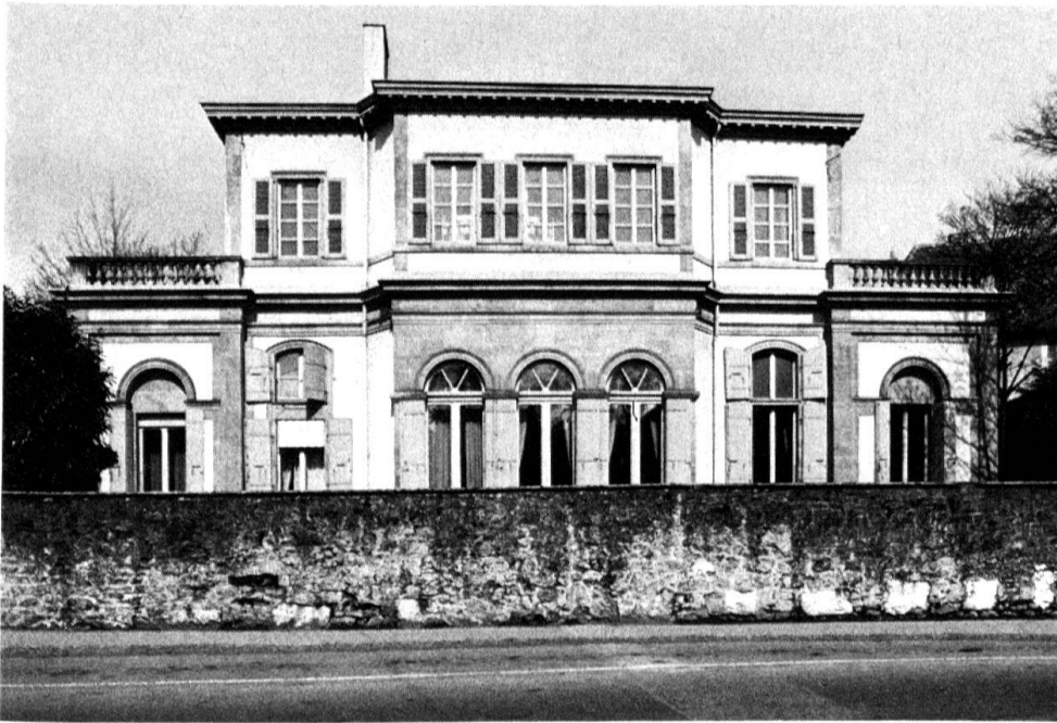
7 Beton statt See: La Petite Rochette du Fau- bourg (siehe Abb. 8) aus heutiger Sicht (Süd- ansicht).
