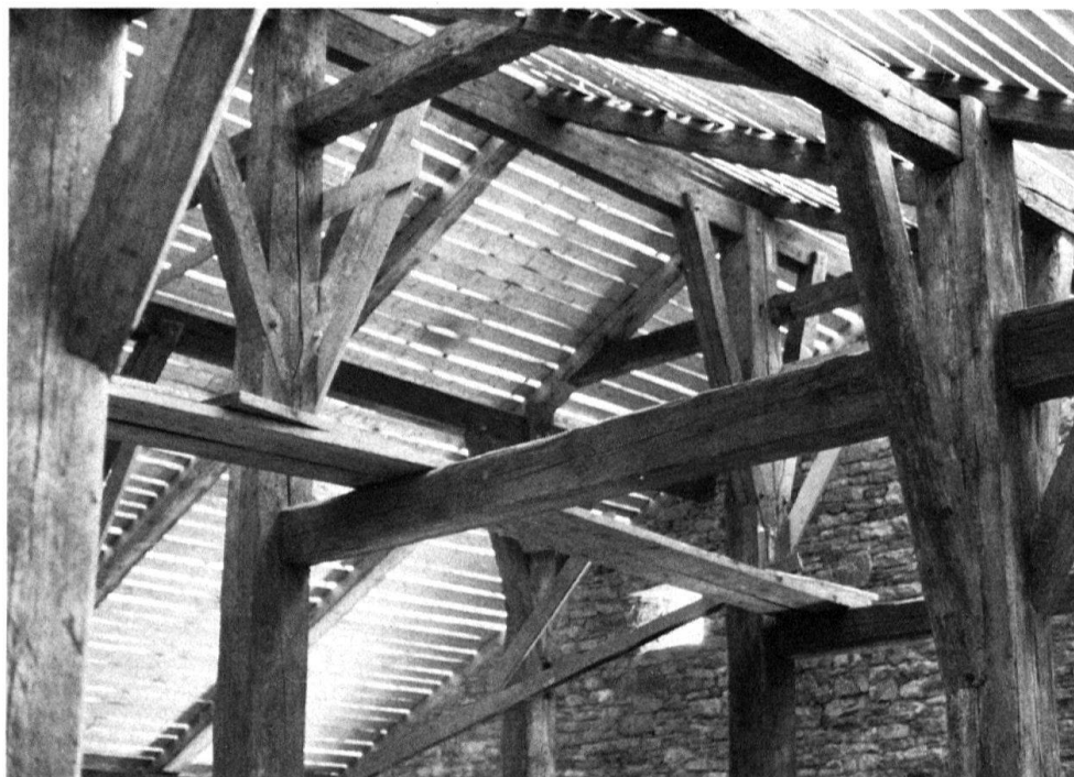
2 La charpente remon- tée à Ballenberg, avec le lattage destiné à sup- porter les bardeaux.
