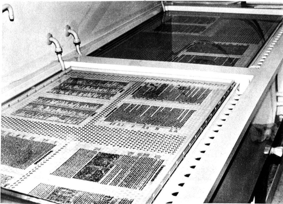
3 Teil einer speziell konstruierten Wannenaufgabe zum Auswaschen von Restchemikalien im Fließwasser. Zu- und Abfluss sind so angelegt, dass jedes Blatt mit der gleichen Menge Wasser umspült wird. Dauer der Wässerung: ca. vier Stunden.
