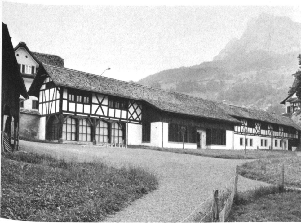
1 Schwyz, Ital Reding-Haus, Ansicht von Südwesten.
