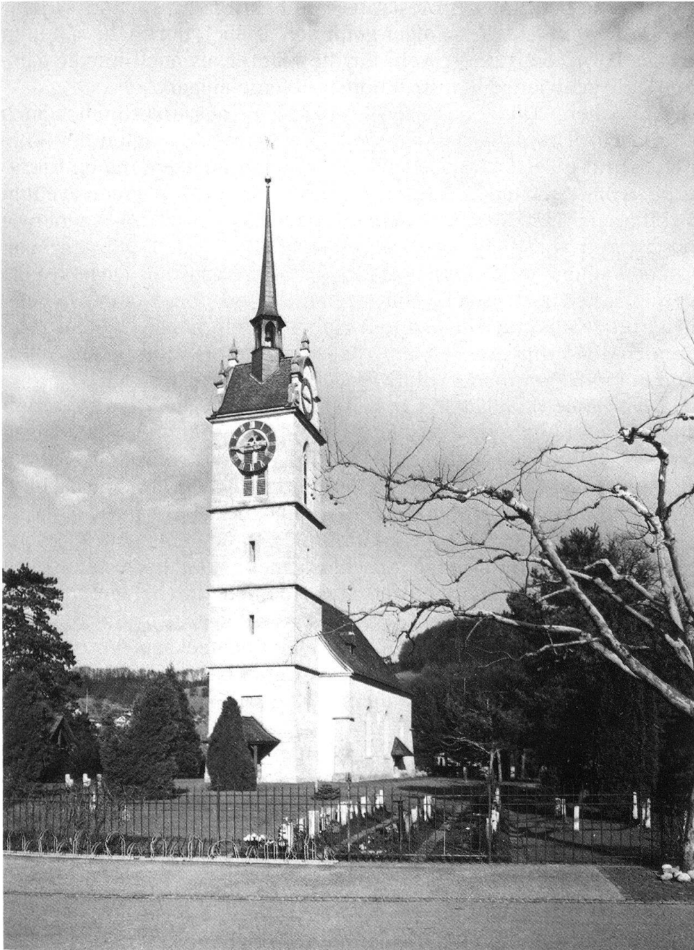
1 Gränichen. Reformierte Kirche. 1661–1663 erbaut von Abraham Dünz I. Ansicht von Südwesten.
