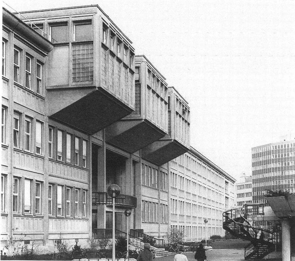
2 Die Eingangspartie nach dem Umbau.
