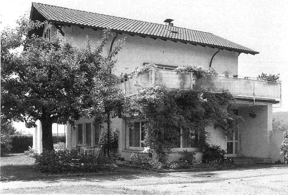
10 Das Haus nach dem Umbau.
