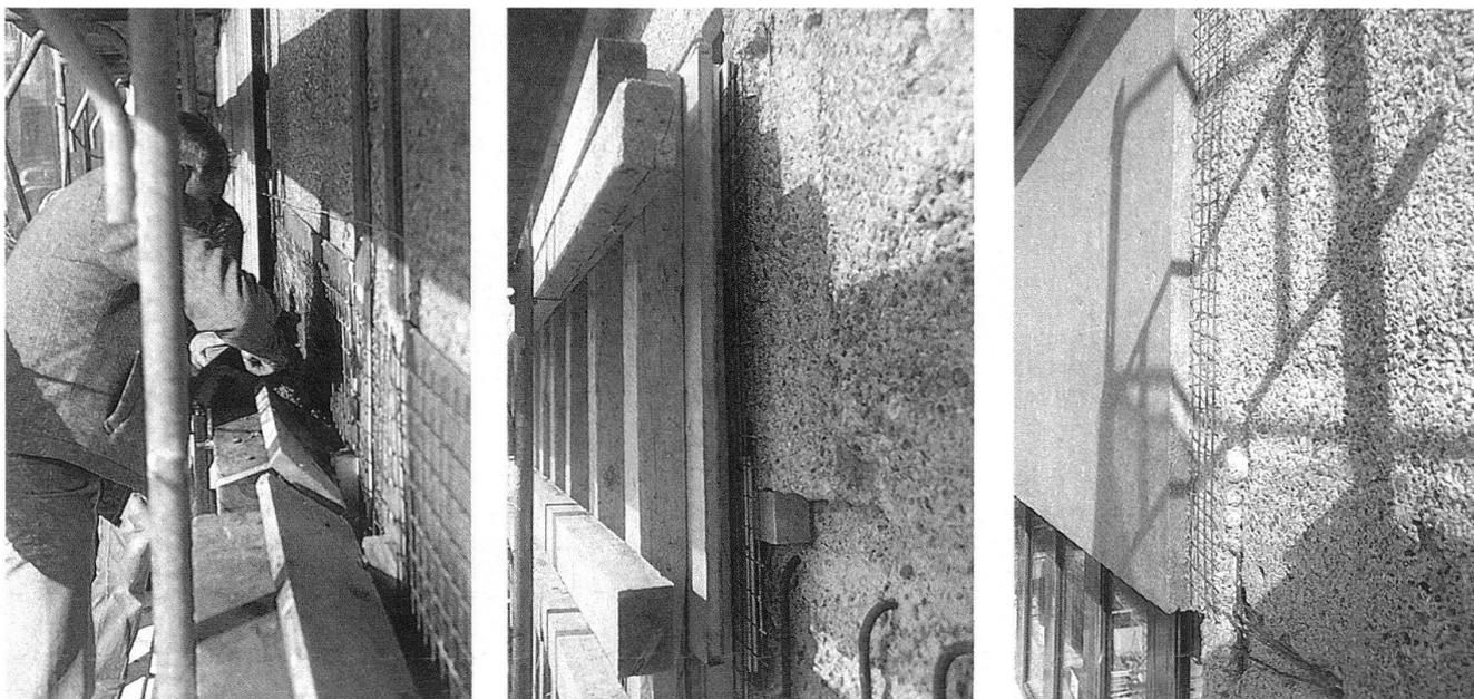
5-7 Verwaltungsgebäude der Städtischen Werke Baden. Montage der 6 cm dicken, neuen Betonschicht; die neue Betonwand bleibt sieben Tage lang eingeschalt; vorbetonierte Wand, Netzarmierung und alte Wand nebeneinander (fotografiert Juli 1987).
