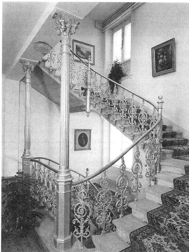
Foto: Flury, Pontresina
