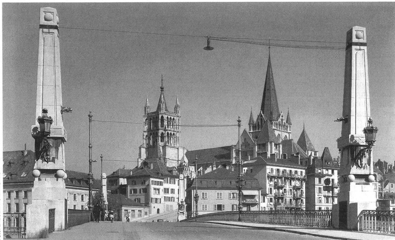
b) Lausanne, östlicher Brückenkopf des Pont Bessières, 1908–1910.
