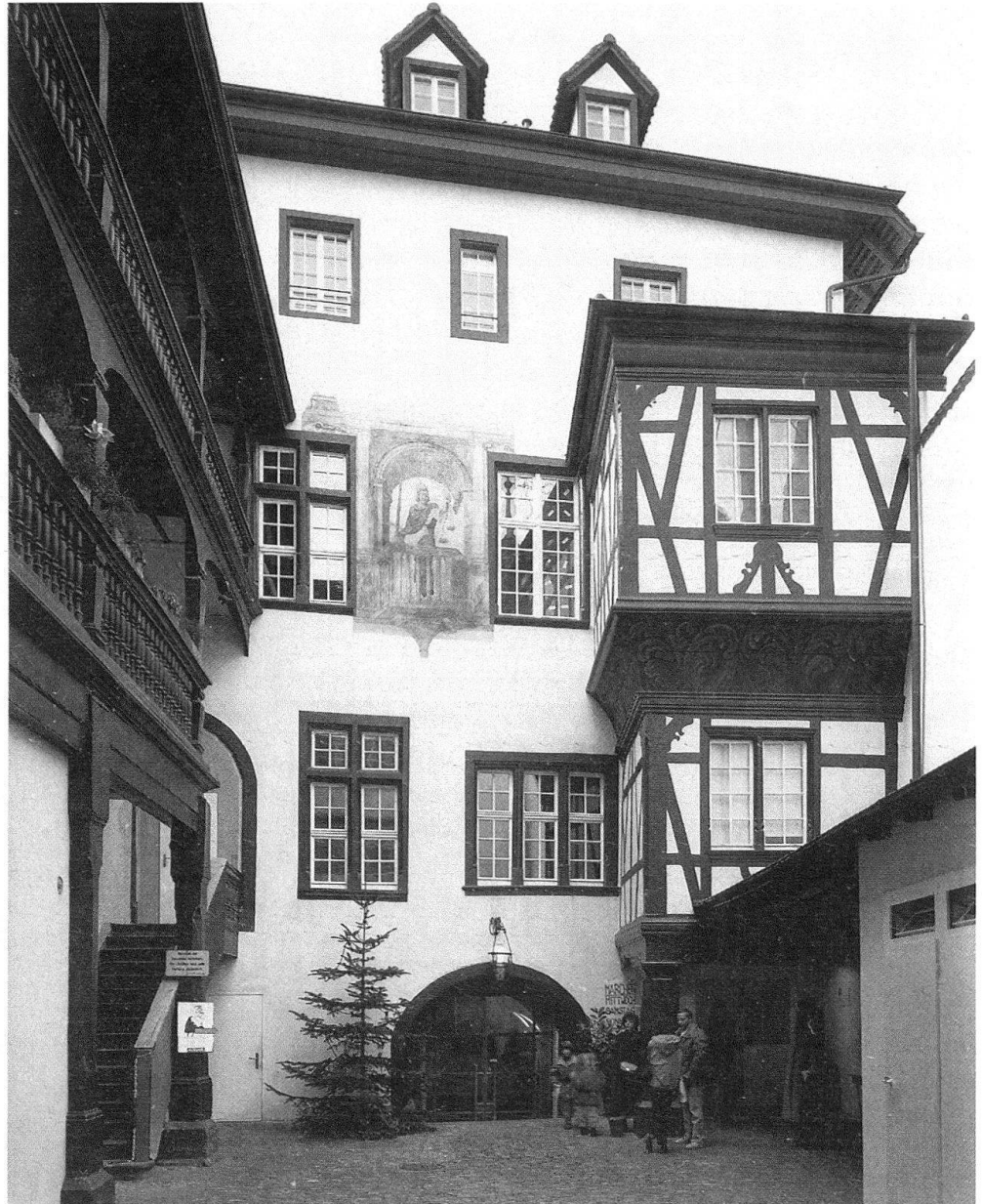
2 Vorderfassade des Spalenhofs mit Wandbild der Justitia, Fachwerkanbau des 17. Jahrhunderts und barocker Laube.
