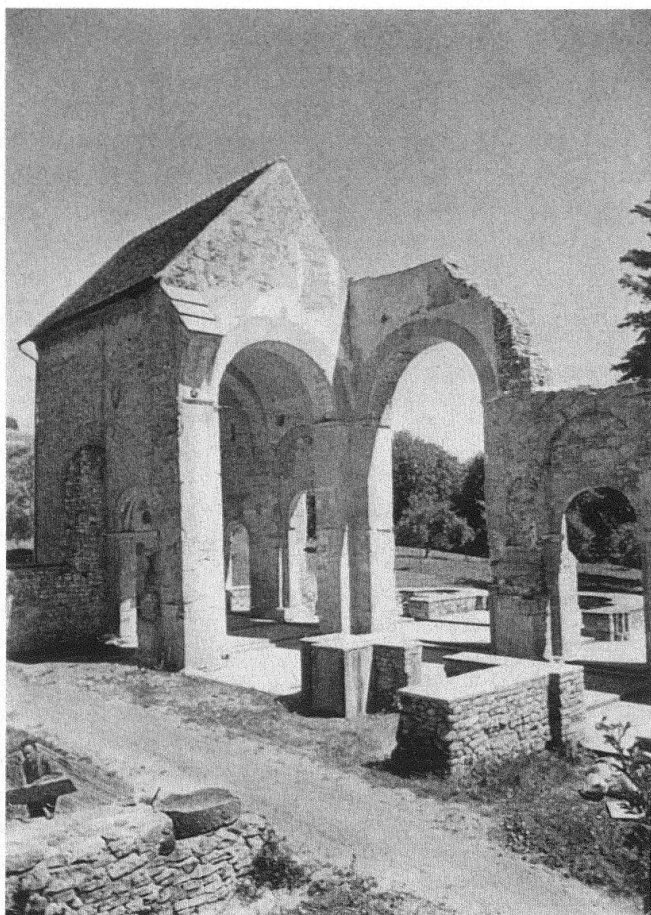
Das Cluniazenserpriorat Rüeggisberg.
