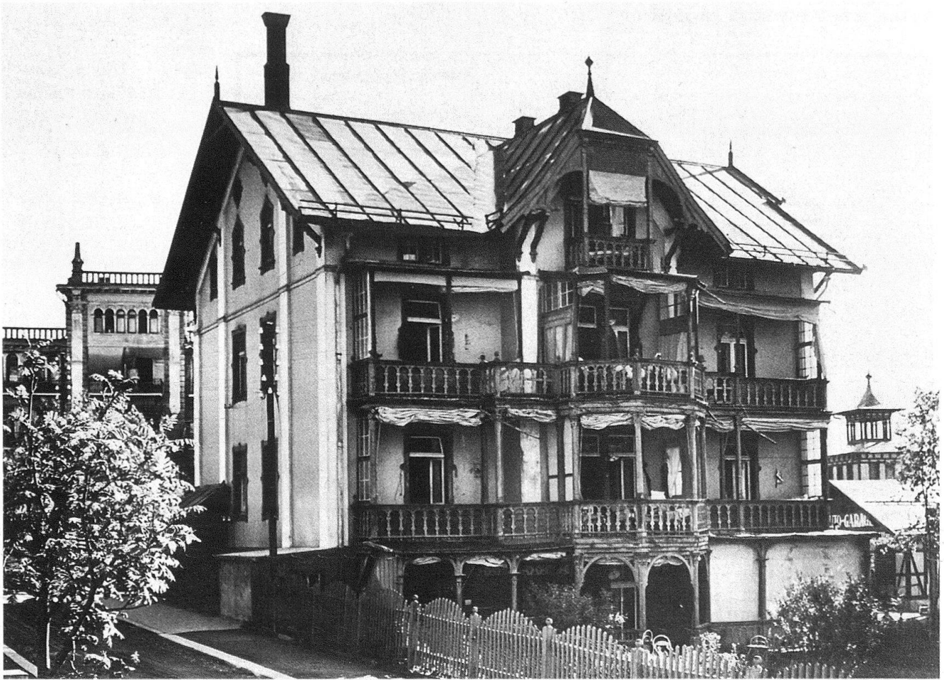
7 Rudolf Gaberel, Villa Sophia in Davos vor dem Umbau 1928.
