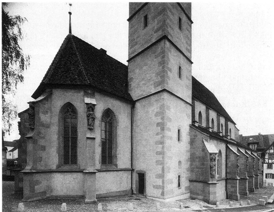
6 Aussenansicht des Chores und der unteren drei Geschosse des Glockenturms von Osten [1481–1483/84].
