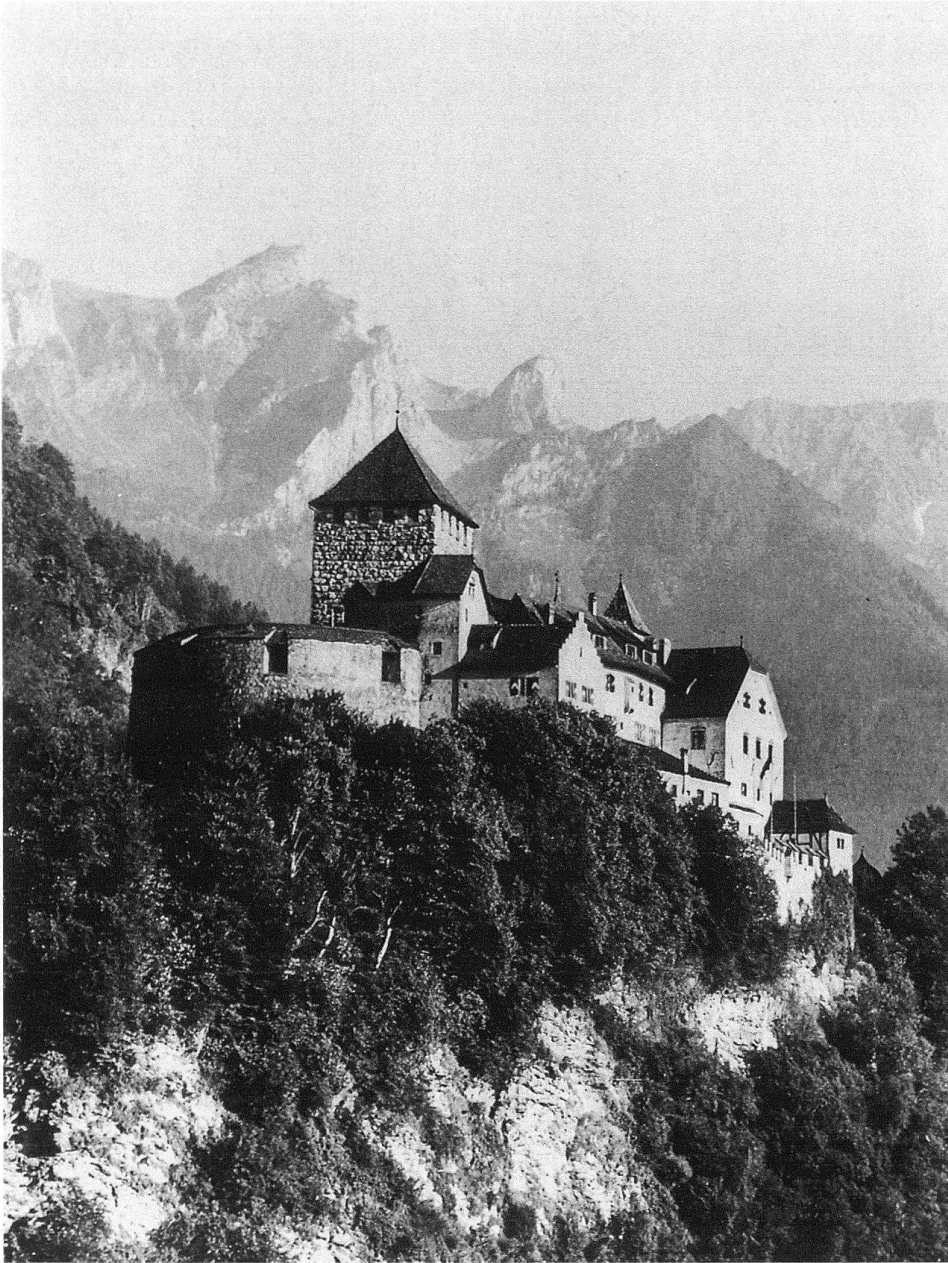
12 Das wiederaufgebaute Schloss Vaduz von Nordwesten. Deutlich überragt der Bergfried die anderen Gebäude, der südwestliche Saalbau (rechts) wurde aufgestockt und hat einen Krüppelwalm bekommen.
