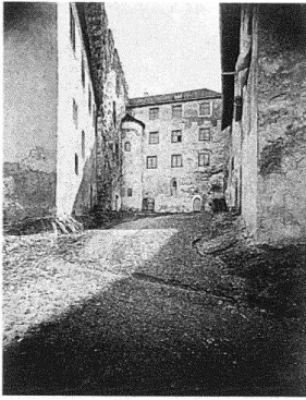
6 Der Schlosshof 1880 mit Blick auf den Kapellentrakt. Unter der neuzeitlichen Aufstokkung ist ein Zinnenkranz sichtbar. Links im Bild der Bergfriedstumpf.
