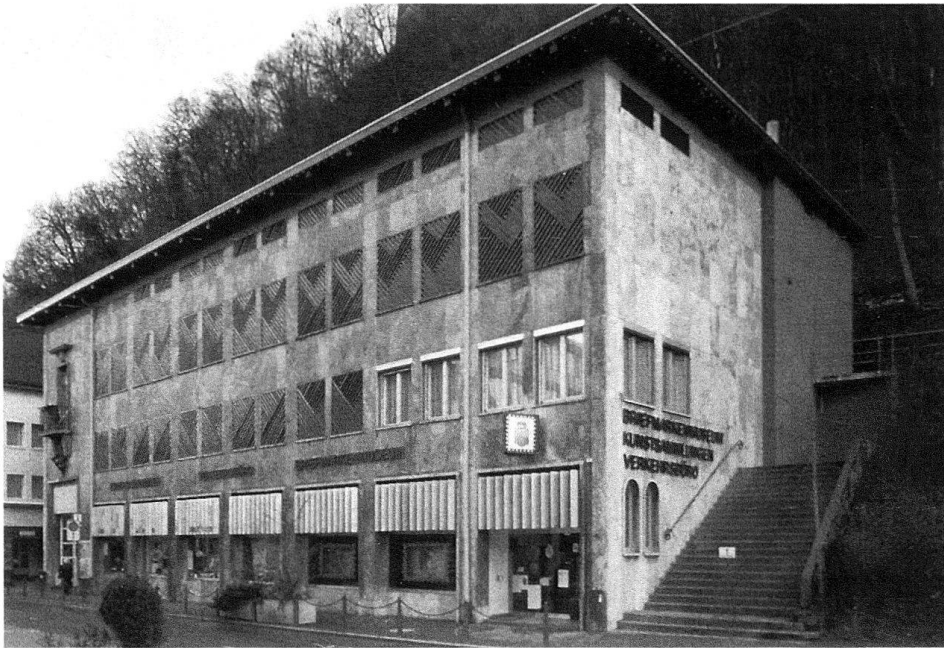
5 Vaduz, «Engländerbau», 1933–34. Architekt: Erwin Hinderer. Das ehemalige Büro- und Geschäftshaus erhielt bei seiner Adaption als Museumsbau profilierte Blechelemente, welche in die Fensteröffnungen gesetzt wurden.
