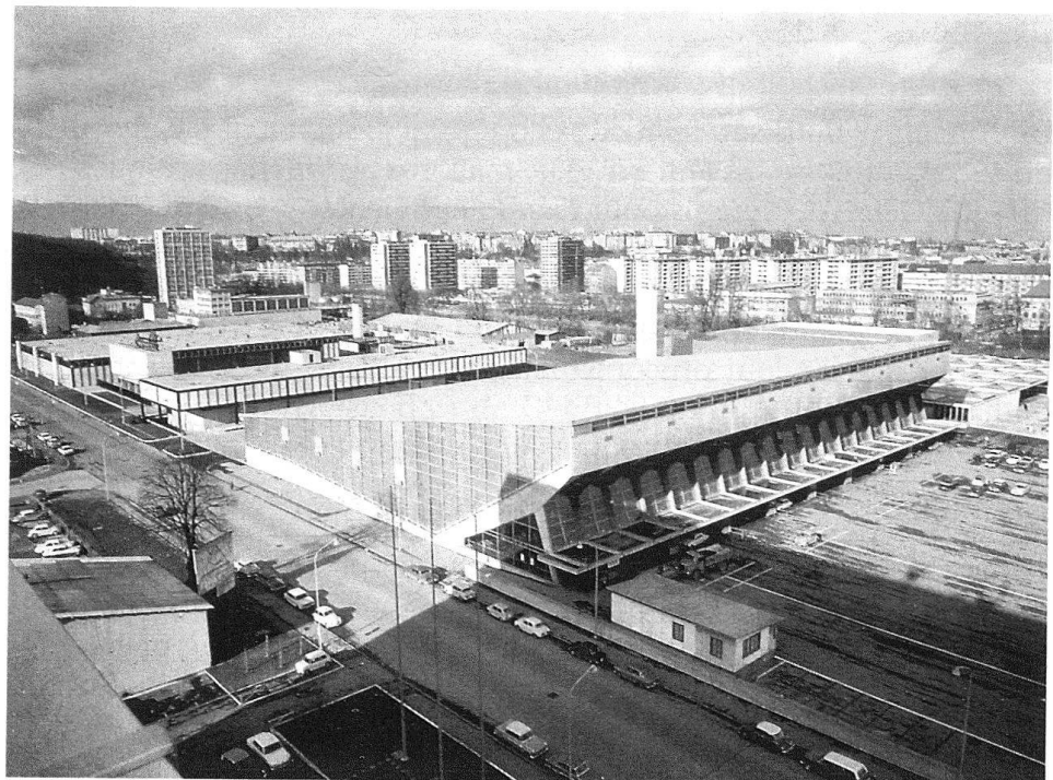
10 Genève, Vue générale du centre sportif des Vernets d'Albert Cingria, Jean Duret et François Maurice (1957–1958).
