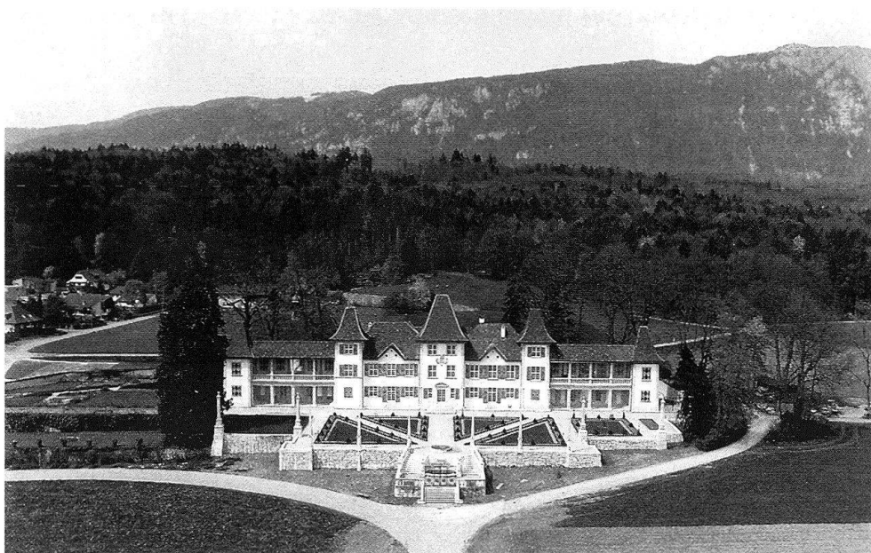
3 Schloss Waldegg. Gesamtansicht Schloss und Gartenanlagen von Süden. Zustand 1991, kurz vor dem Abschluss der Restaurierungs- und Rekonstruktionsarbeiten.
