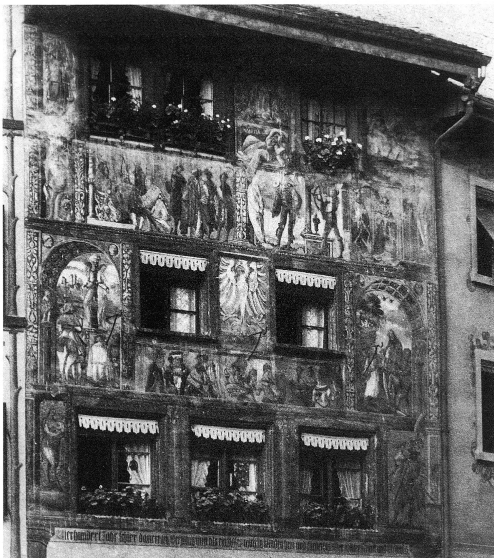
8 Fassadenmalerei am Haus «zum weissen Adler» in Stein am Rhein, Thomas Schmid zugeschrieben, um 1520.
