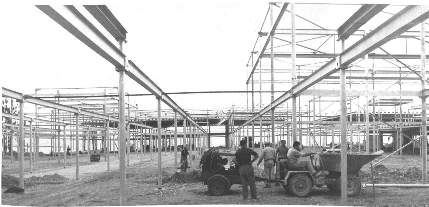
5 La structure: un squelette d'acier sans fioritures s'exhibe en toute ingénuité.
