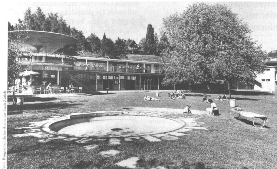
Strandbad Wollishofen, erbaut 1939 vom Stadtbaumeister Hermann Herter.
