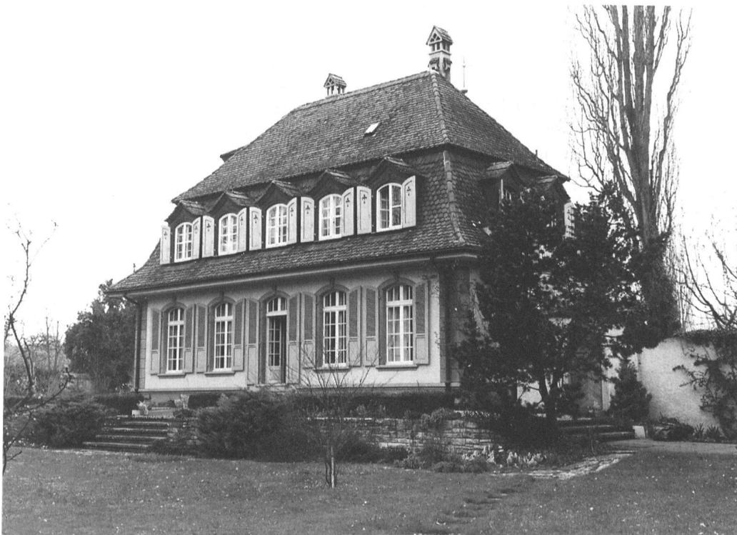
10 Gemeinde Thun, Dürrenast, Seestrasse 53, Villa des Thuner Architekten Alfred Lanzrein von 1929. – Repräsentativer Putzbau mit hohem Mansarddach und fein gearbeiteten Kunststeingliederungen; inspiriert von bernischen barocken Landsitzen. Gehört zu den überzeugendsten Villenbauten dieser Epoche in Thun. Einstufung: schützenswert.
