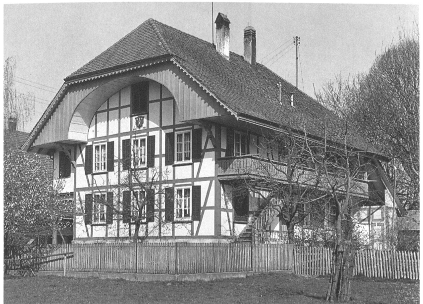
7 Niederösch: Beispiel eines im Hinweisinventar als «in der Gesamtform erhaltenswert» eingestuftes Stocks von 1883. Der ursprünglich erhaltene Bau wurde nicht zuletzt wegen seiner dem Inventarisator bekannten guten Innenausstattung aufgenommen.
