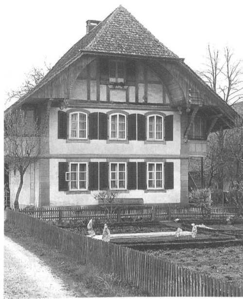
6 Niederösch: Beispiel eines im Hinweisinventar als «wertvoll» eingestuftes, schmuckes, ursprünglich erhaltenes Stöckli mit Ofenhaus, welches sich durch qualitativ hochwertige Sandsteingliederung und gute Zimmermannsarbeit auszeichnet, erbaut 1821.
