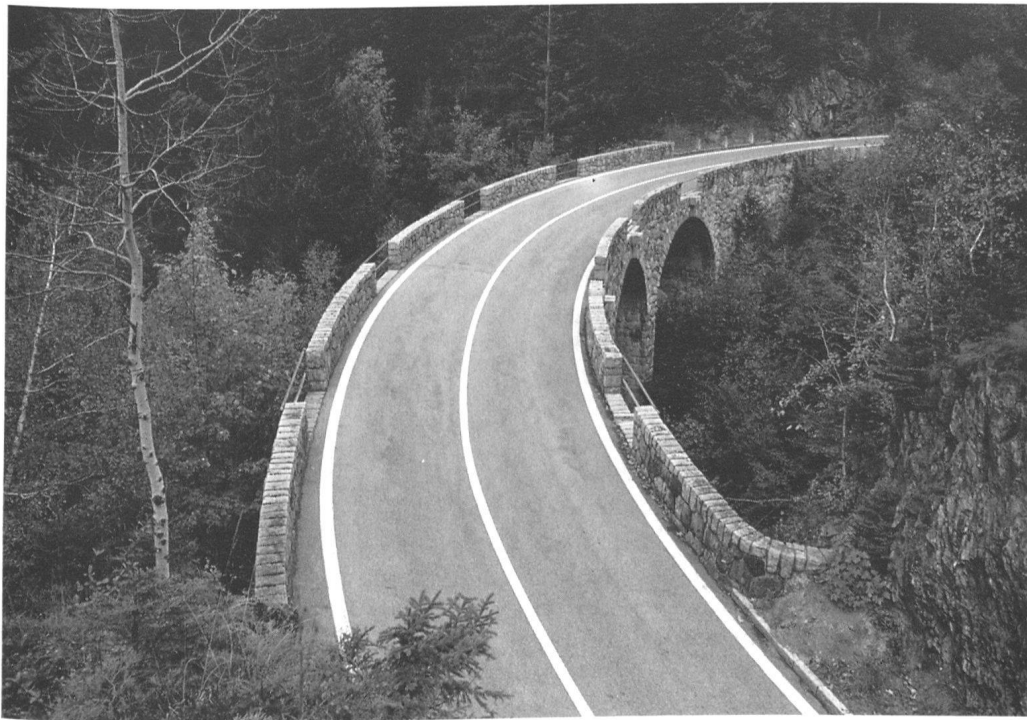
9. Sustenstrasse 1946; Abschnitt zwischen Chäppeli und Rossweidhubel, Nesselental. IVS-Strecke BE 15.8. – Moderne, für den touristischen Automobil- ausflugsverkehr konzipierte Alpenstrasse mit durchgehendem Gestaltungskonzept. Mehrbogi- ge Eisenbetonbrücke in einer Rechtskurve. Komplette Verblen- dung mit Granithausteinen, Brüstungsmauern alternierend mit Eisenröhrengeländer, vorste- hende Wasserabflüsse.
