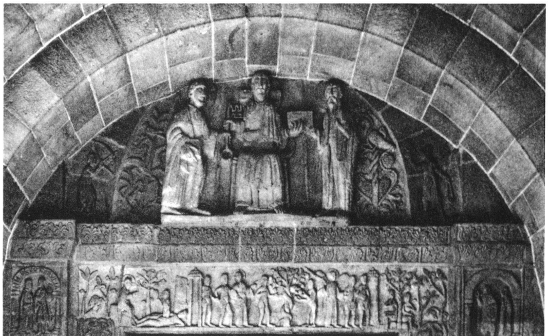
4 Andlau, ehemalige Abteikirche, Portal der Westwand.
