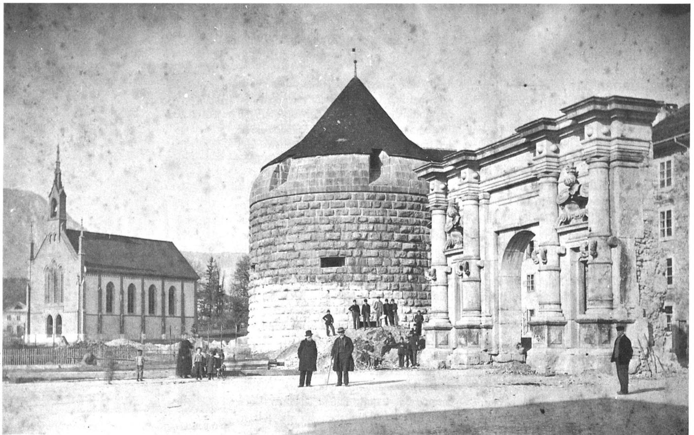
Solothurn, Blick über den Kosciuskopplatz (heute Amthausplatz) gegen Nordosten. Von rechts nach links: der Mittelteil des äusseren Bieltors, der Buristurm nach Abbruch der Marienschanze und die alte protestantische Kirche. Fotografie von C. Rust, um 1871.
