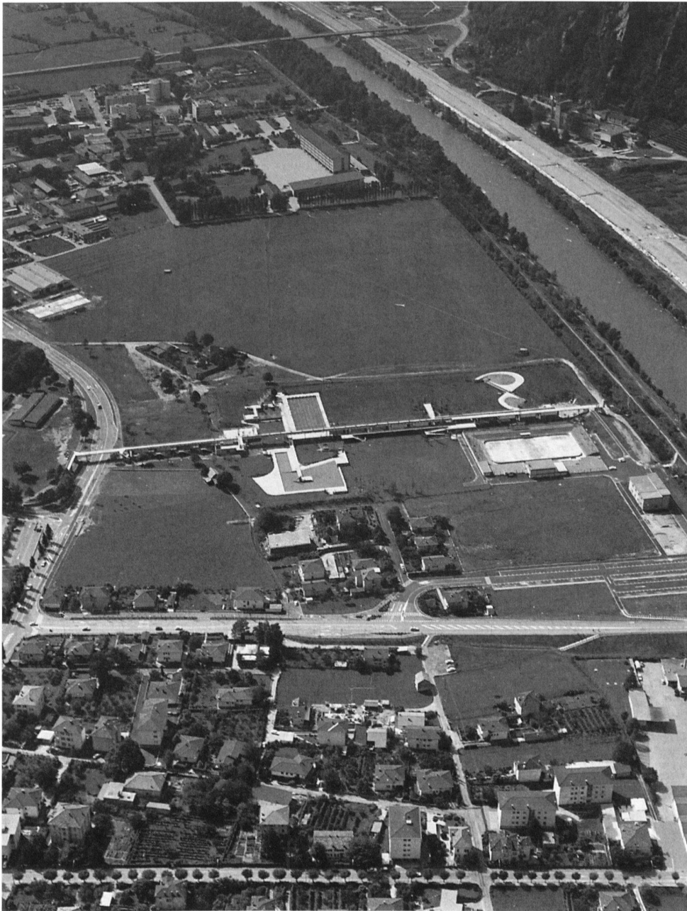
2 Aurelio Galfetti, Flora Ruchat, Ivo Trümpy, Bagno pubblico, Bellinzona 1970. Foto aerea. – Il tema del rapporto tra l'architettura e il luogo è tradotto nel costruito.
