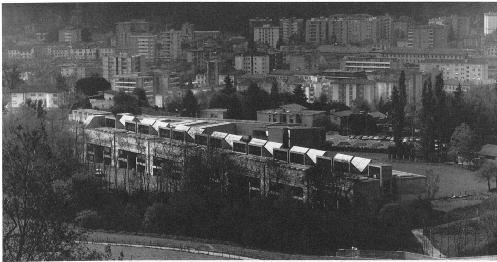
14 Mario Botta, Scuola media, Morbio inferiore, 1976. – L'architettura diviene un segno forte per qualificare la periferia della città.
