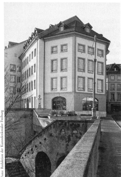
Freiburg, Kopfbau vor der Zähringerbrücke, Bauwerk des 20. Jahrhunderts.
