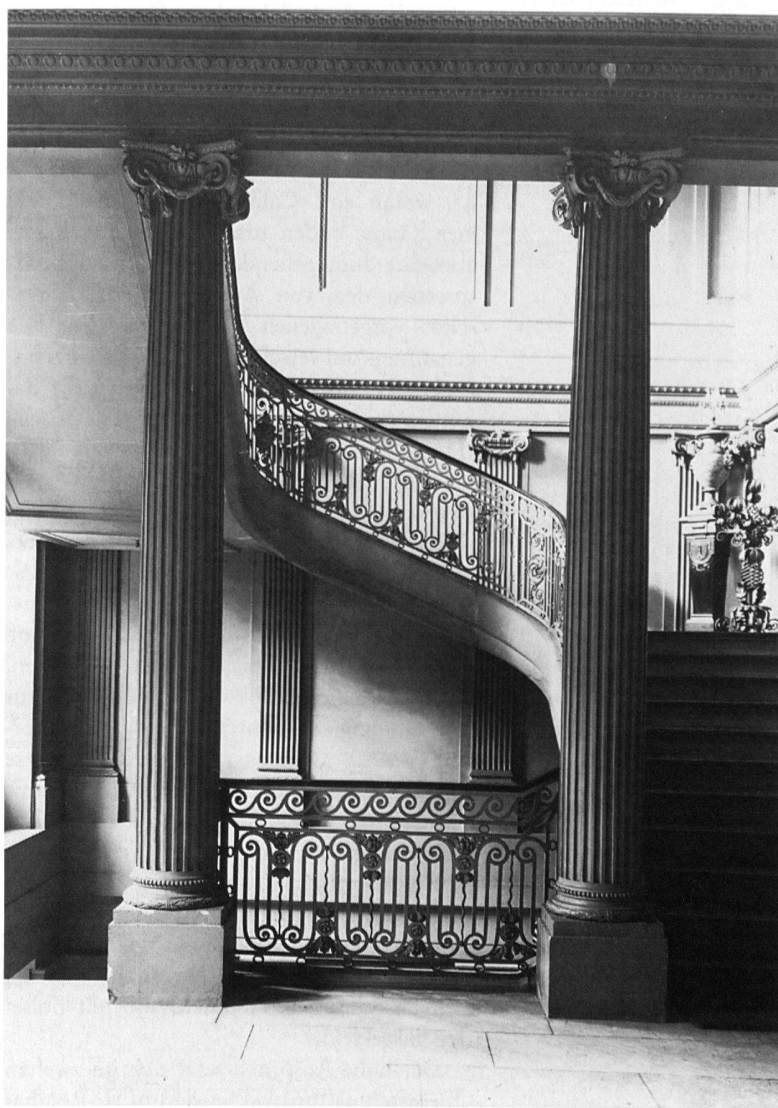
5 Basel, Haus «Zum Kirschgarten», Blick aus dem Vestibül der 1. Etage in das Treppenhaus.
