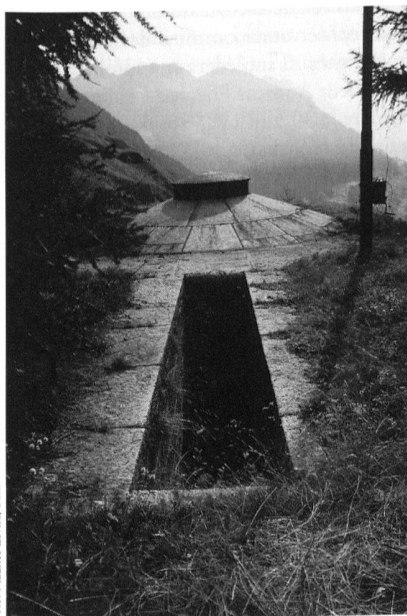
Motto Bartolo/Airola, versenkbarer Panzerturm für eine Kanone (5,3 cm), der 1904–1905 in einen Beobachtungsstand (Ost) umgebaut wurde.
