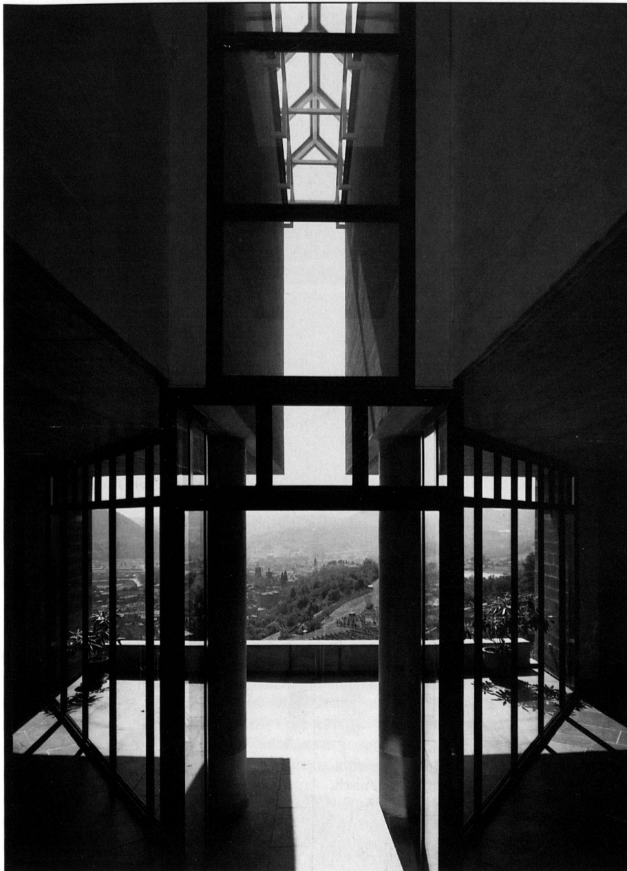
4 Der Schlitz: Einfamilienhaus in Morbio Superiore, 1983. – Nicht Fenster, sondern senkrechte Lichtstreifen schneidet Botta in die Wände.
