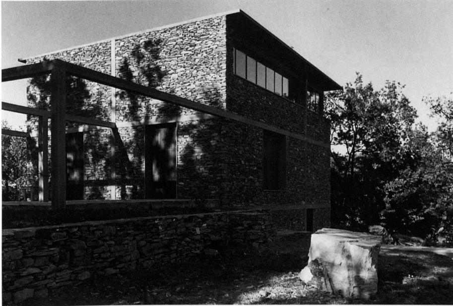
4 Tavole (I), Steinhaus, Projekt 1982, Ausführung 1985/88. – Das Betonskelett, im Inneren kreuzförmig angelegt, ist aussen mit Bruchsteinen der Umgebung ausgefüllt.
