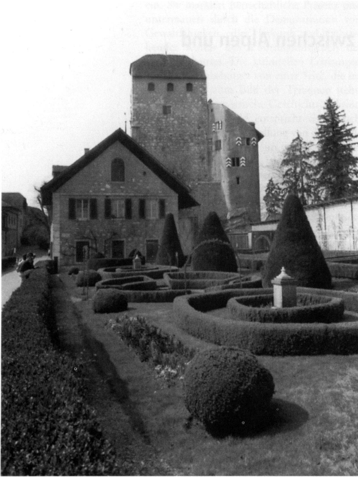
2 Wildeggen AG, Hauptturm des 13. Jahrhunderts mit jüngeren Anbauten.
