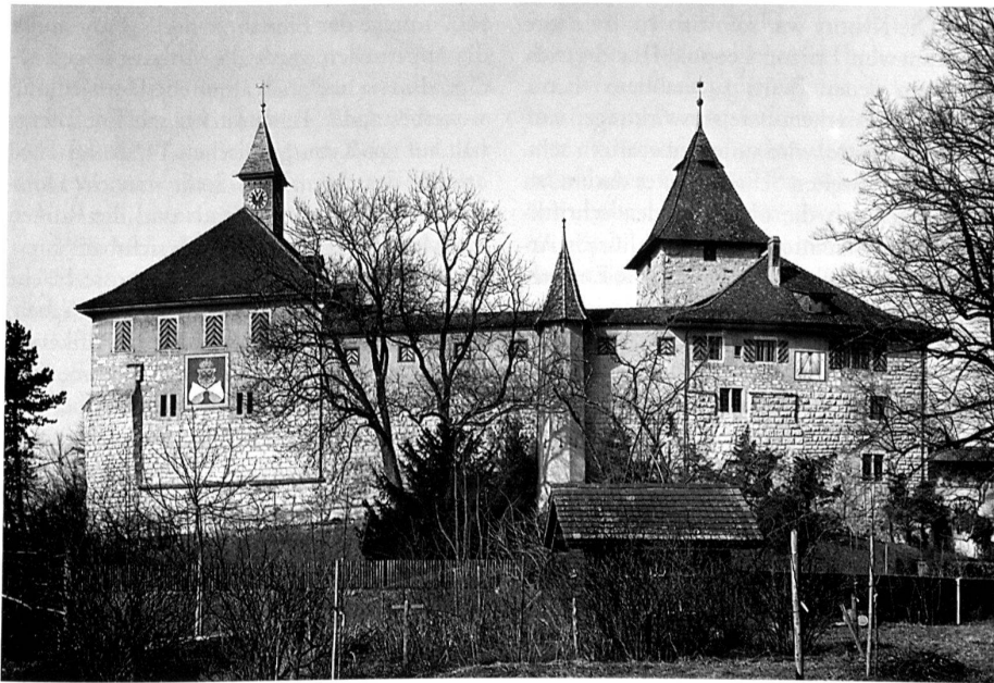
9 Die Kyburg von Südosten, 1972. Die Renovation von 1925 ff. hat das Mauerwerk sichtbar gemacht und vor allem Umbauten im Bereich des Bergfrieds, des Mehrzweckgebäudes und des südlichen Wehgangs gebracht.
