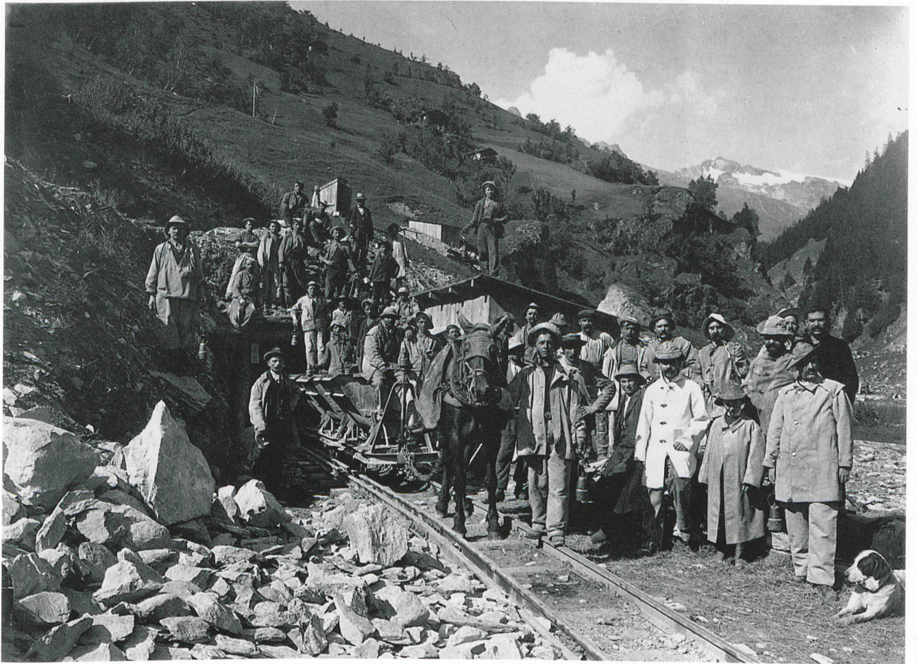
«Fototermin» für die Tunnelarbeiter vor dem Stolleneingang, Gelatinesilberkopie auf Papier, matt, 17,8×22,8 cm Arbeiterschaft (mit Pferd) vor demselben Stolleneingang (kein Schnee), (Sammlung Herzog, Schweizerisches Landesmuseum Zürich, LM100178.15).
