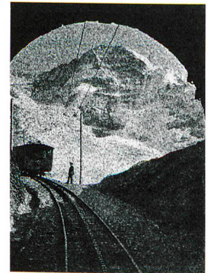
6 Jungfraubahn, elektrisch betriebene Zahnradbahn.
