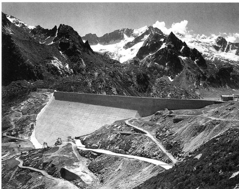
Vicosoprano, Staumauer Albigna der Elektrizitätswerke Zürich (EWZ).
