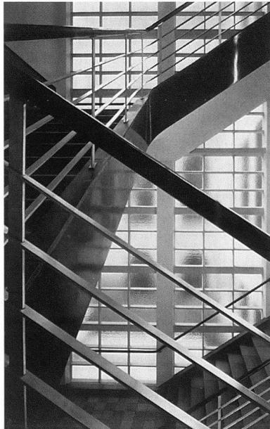
Otto R. Salvisberg, Maschinenlaboratorium und Fernheizkraftwerk der ETH Zürich, Treppenhäuser nach der Renovation. – Die originale Farbgebung wurde aufgefrischt, original sind auch die Bodenklinkerplatten und das Geländer.
