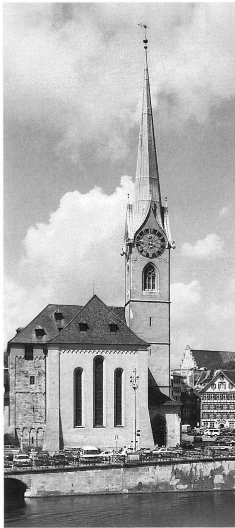
4 Zürich, Fraumünsterkirche von Osten, Aufnahme 1987. – Der nach 1218 ehrgeizig begonnene Nordturm erreichte seine heutige Höhe erst 1728/32. Der um 1230 begonnene spätromanische Chor orientiert sich mit den drei hohen, gestaffelten Rundbogenfenstern und dem abschliessenden Blendbogenfries – wohl in beabsichtigter Konkurrenz – an der Chorfassade des Grossmünsters.
