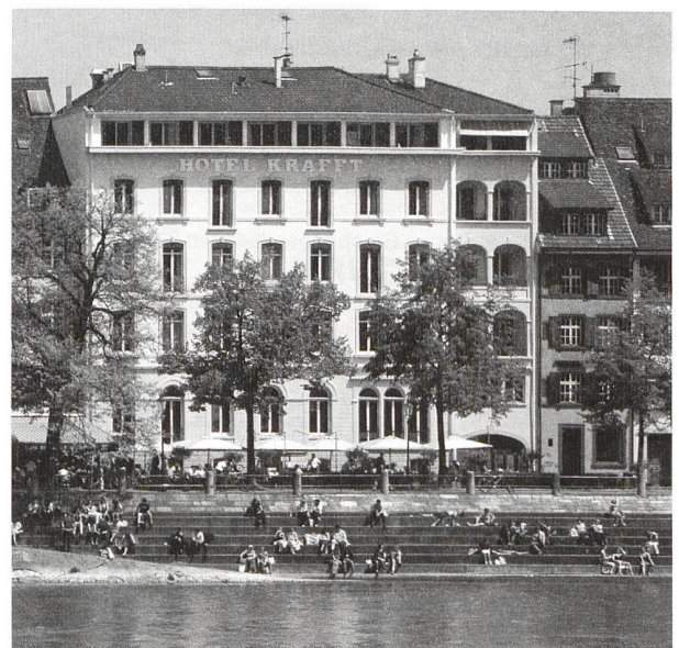
Hotel Krafft, Basel, Fassade an der Rheinpromenade. (Dirk Altenkirch, Karlsruhe)
