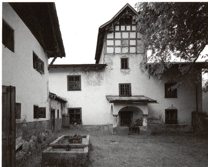
Luzein, Sprecherhaus am Landsgemeindeplatz. (Heinrich Helfenstein, Zürich)
