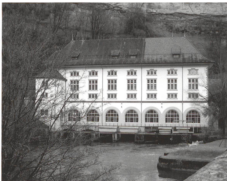
Fribourg, Karrweg 12, Usine électrique de l'Oelberg, construite en 1908-1910. (© Service des biens culturels)
