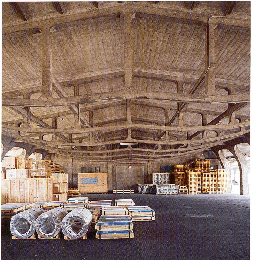
Magazzini Generali in Chiasso: Dachkonstruktion der Vorhalle mit den nach innen geneigten Stützen und Dachbindern mit polygonal gebogenem Untergurt
