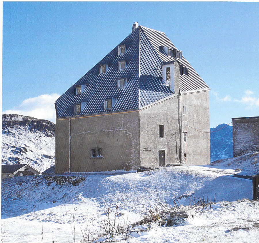
Gotthard-Hospiz: eine tragende Holzkonstruktion im Gebäudeinneren, Fassade und Treppenhaus in Massivbauweise
