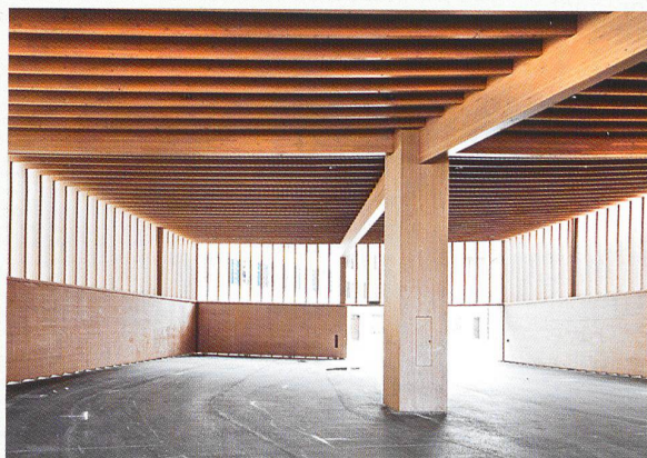
Markthalle in Aarau: erinnert in der inneren Gestalt an mittelalterliche Korn- oder Zeughäuser
