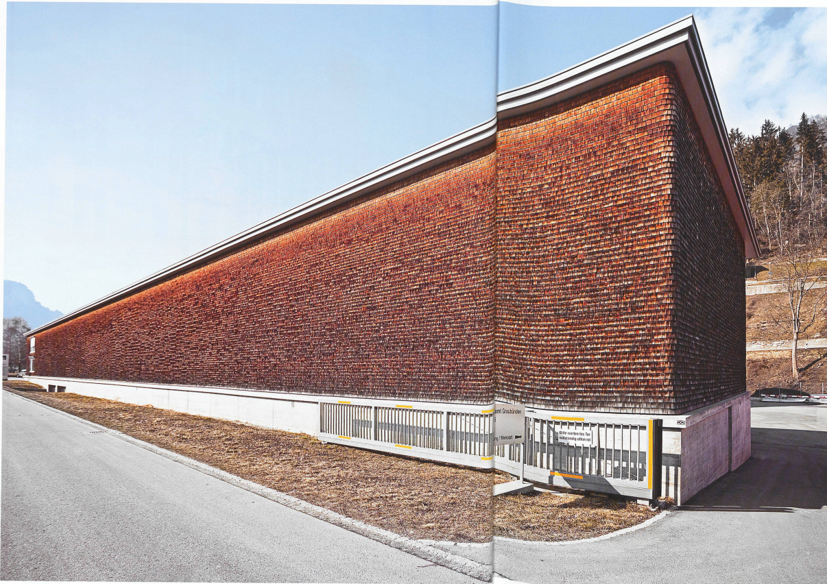
Werkhof aus Holz in Ilanz: 150'000 Schindeln aus Gebirgsläuche auf einer Wandfläche von 1500 m 2 . Architektur: Albertini&Zanoni, Chur, 2003 (links) Werkhof aus Holz in Flums: Architektur: Schlegel-Engler, Buchs, 2009 (rechts)
