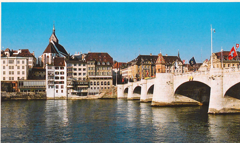
Mittlere Brücke in Basel, erbaut 1903–1905
