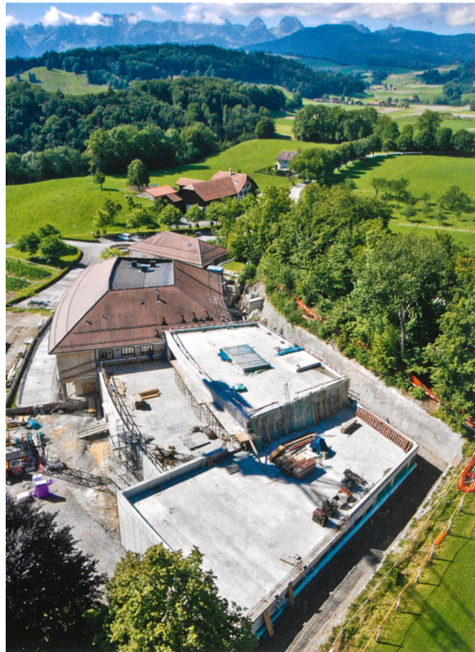
Die Abegg-Stiftung mit dem neuen Anbau im Rohzustand (Sommer 2010)
