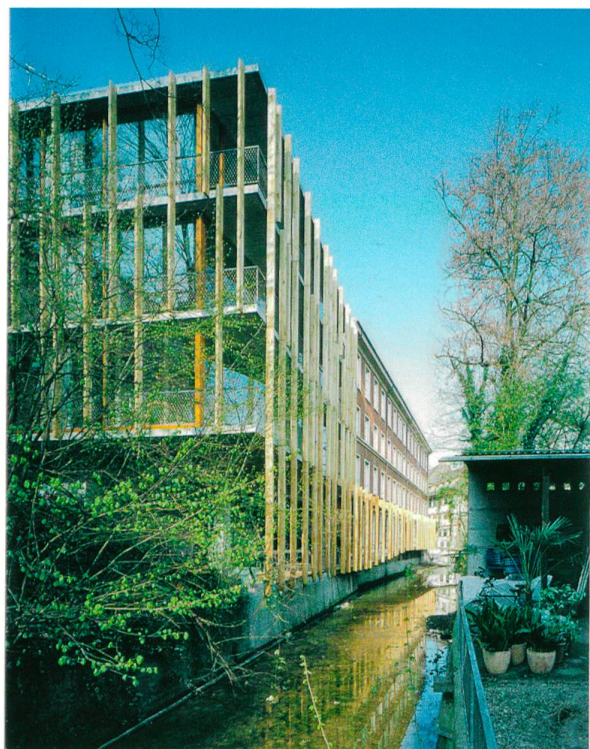
Erweiterungsbau mit Eichenholzlamellen und raumhoher Verglasung. Foto Ruedi Walti
