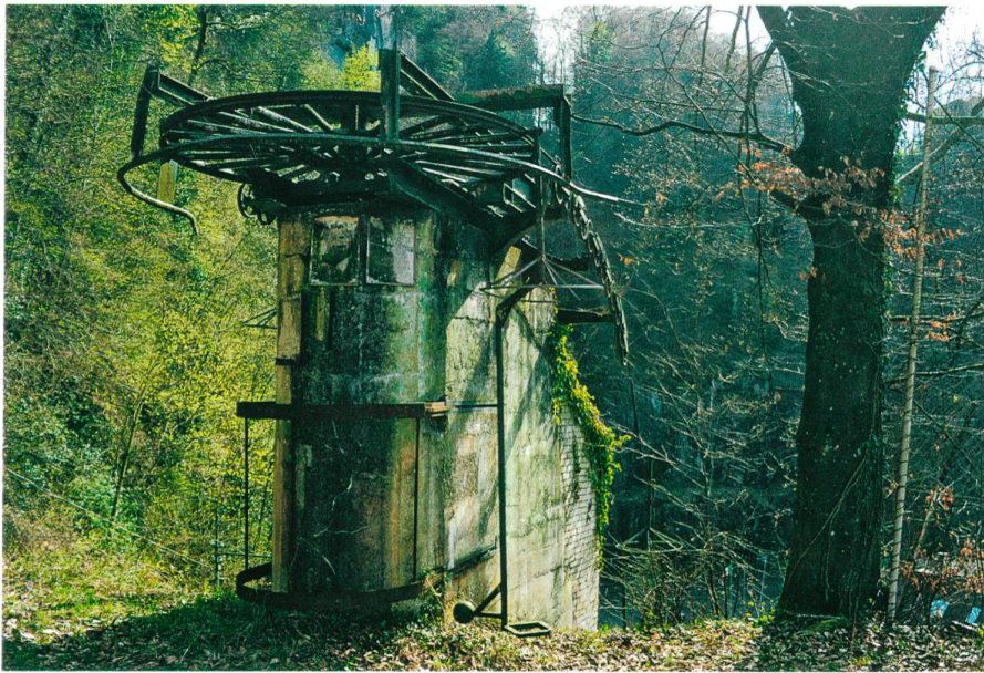
Stehlift Endstation Zustand 2011. Foto Martin Fuhrer, London
