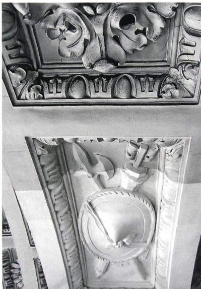
**Kathedrale Solothurn**, Reinigungsmuster: In einem ersten Schritt wurde der lose Staub mit einem Pinsel oder Spezialstaubsauger abgenommen (siehe zweitoberster Streifen), anschliessend die Stuckaturen mit Gummigranulat fein abgestrahlt und dann mit speziellen Reinigungsschwämmen trocken gereinigt. Dann erfolgte eine feuchte Nachreinigung (siehe ganz unten). Foto C. Fontana
