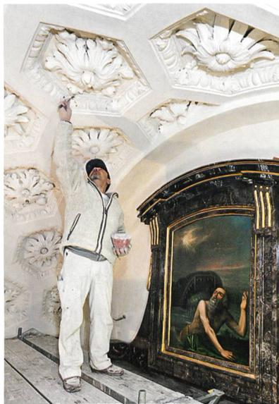
deren man auch die gesamte Elektrik erneuerte. Die optimale Reinigungsmethode wurde durch vergleichende Versuche eruiert.<sup>9</sup> Die besten Ergebnisse erzielte ein mehrstufiges Trockenreinigungsverfahren, das mit einer feuchten Nachreinigung kombiniert wurde. Dies ermöglichte es, bis anhin ungestrichene Stuckaturen nun nicht neu streichen zu müssen. Farbliche Korrekturen wurden auf ein Minimum reduziert und grösstenteils mit Kalklasuren ausgeführt.
