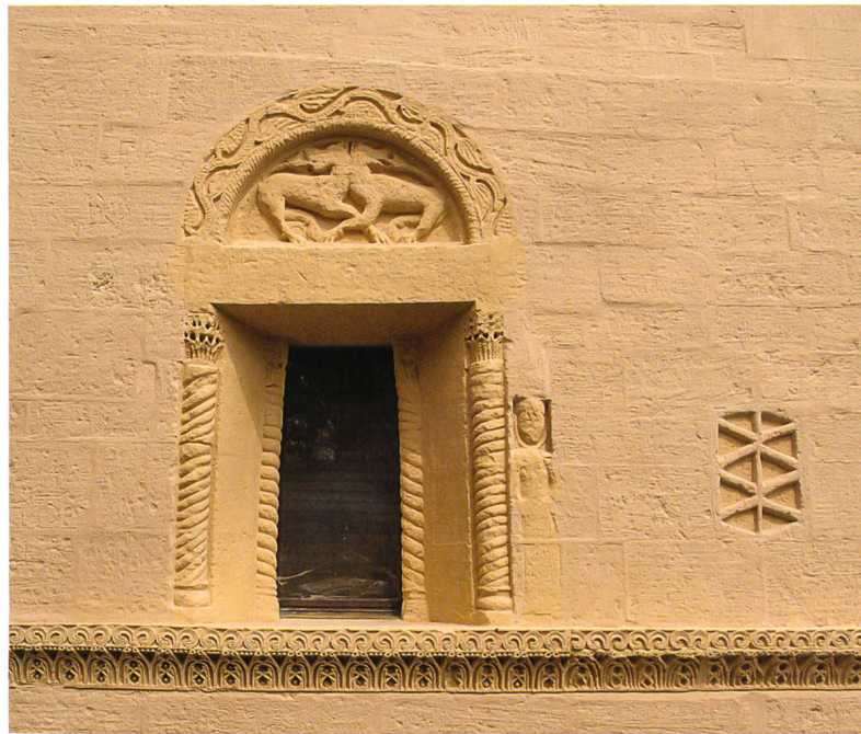
Fig. 16 Mise en valeur du décor par un jeu de deux tons d'ocre lors de la restauration de 2009 (photographie T. Châtelain, BPU/OPMSNE, 2011)
