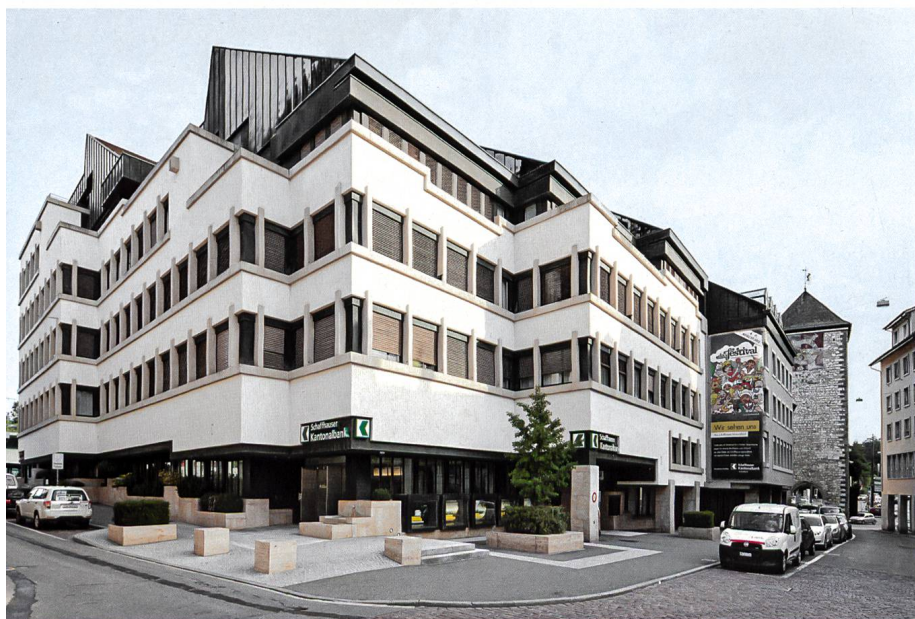
Kantonalbank in Schaffhausen, 1963–1966 von Förderer, Otto, Zwimpfer
